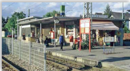
Der alte OEG-Bahnhof, hier noch mit Kiosk, wurde nach jahrelangem Leerstand im Jahr 2008 abgerissen
