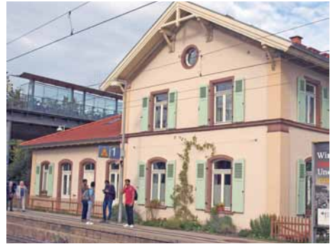
Und das ist der heutige Zustand nach der Renovierung
